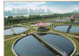
水处理 Water Treatment
